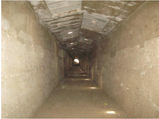
Lungo corridoio d'ingresso
